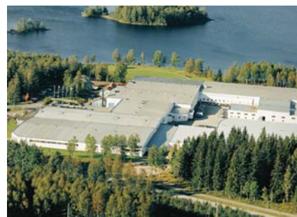
Systemair - г.Скинскаттеберг, Швеция
